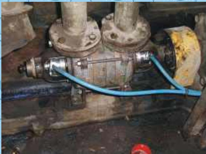
Gleitringdichtung Typ 22GF eingebaut in der Pumpe S42DT von HYDRO-VACUUM
