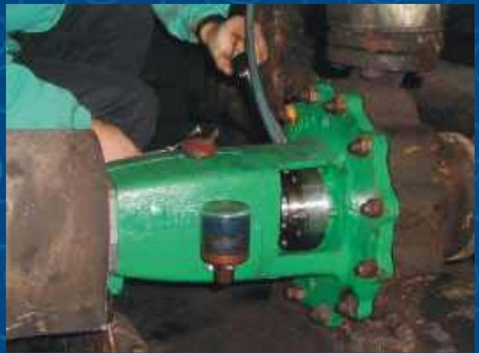
**Gasgeschmierte Gleitringdichtung Typ 45GF eingebaut in der Pumpe 5A25A von WAFAPOMP**
