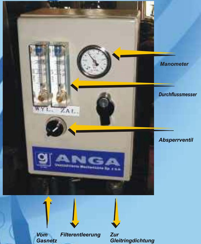
Das Gasversorgungssystem ermöglicht einen einwandfreien Betrieb der gasgeschmierten Gleitringdichtungen. Das System ist so auszulegen, dass die folgenden Funktionen erfüllt werden:
